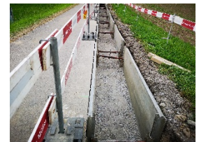
Grabenfüllung Rütistrasse
