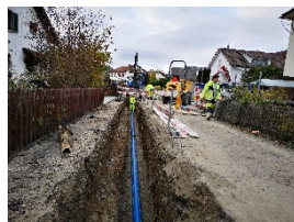
TWV-Leitung PE 160 im offenen Graben
