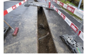
Graben für die gemeinsame HA-Leitung – im Bad
