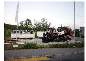
Spülbohrmaschine vor Einsatz
