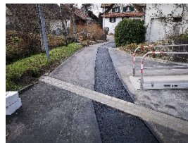
Strassenbelagseinbau ohne Deckbelag Im Bad
