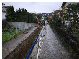
Leitungsgaben Aufgent Grabensohle 1.5 m
