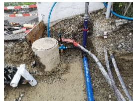
Koordination im Graben beim Hydrant Nr. 113
