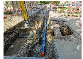
Verlegung TWV-Rohr PE 160 im Graben, Güpfstrasse
