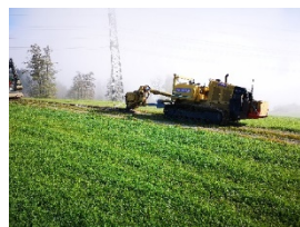
Grabfräse für die Verlegung der Quellwasser-Leitungen
