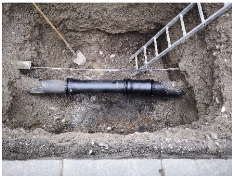
Reparierte TWV-Leitung (GG 200)
