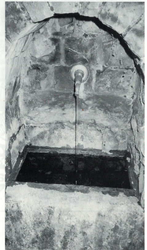
In der Stützmauer am Haldenrank eingelassener Brunnen an der Haldenstrasse 44.
