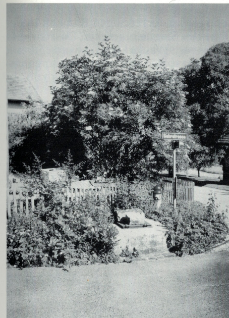
Der Verteilschacht an der Gehr-/Frohmoosstrasse, links neben dem Hydranten und der Strassentafel
