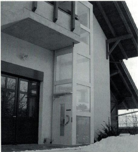
Behindertenlift zum Werkgebüdesaal
